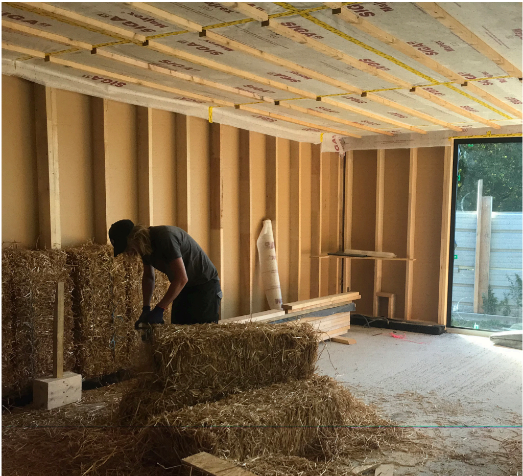
Mur en ossature bois et isolation paille
