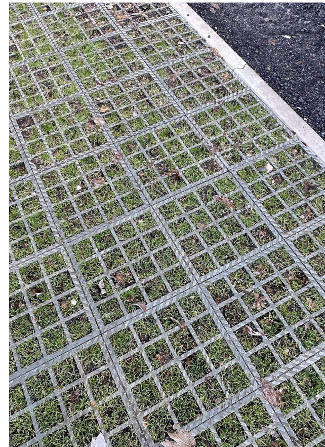
Parking végétalisé avec phyto-épuration en sous-sol
