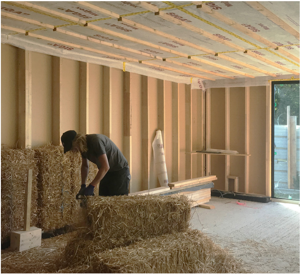
Mur en ossature bois et isolation paille
