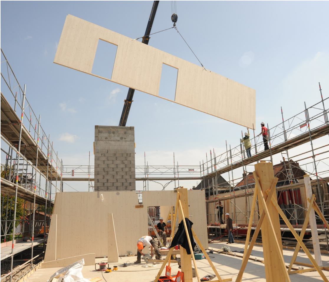
Bâtiment préfabriqué en CLT et assemblé sur site
