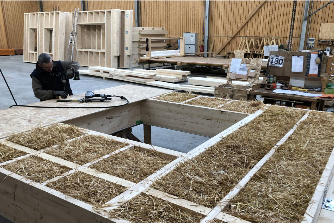
Préfabrication de mur en caisson bois/paille
