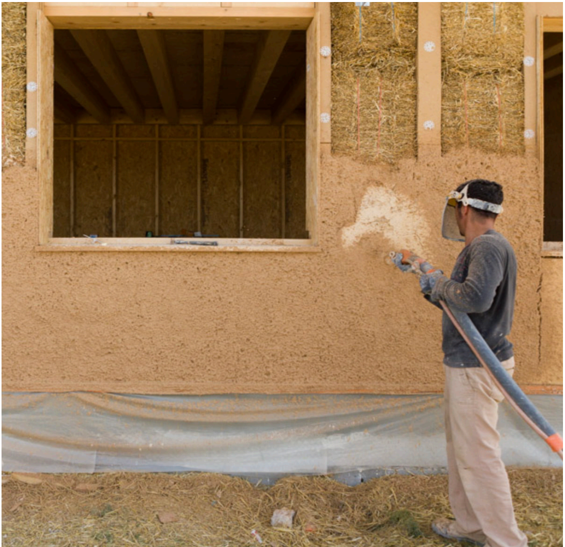
Application de terre projetée sur mur bois/paille
