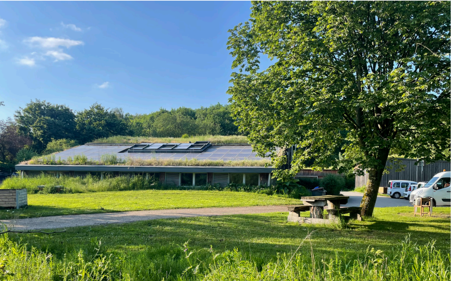
Toiture végétalisée drainante et panneaux photovoltaïques
